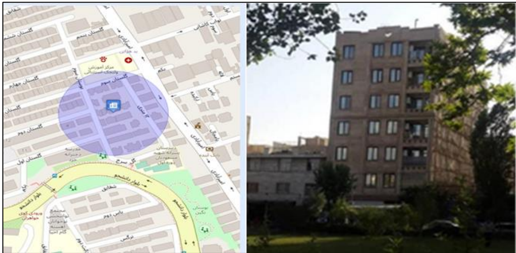
شکل ۲. موقعیت و نمایی از ساختمان مسکونی انتخاب شده در منطقه ۱ تهران (کوی ۱۷ شهریور - محله ولنجک)
