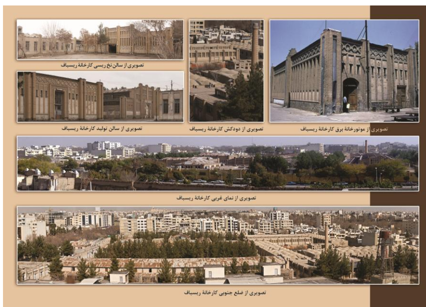
شکل شماره ۴: تصاویری از کارخانه ریسباف اصفهان
