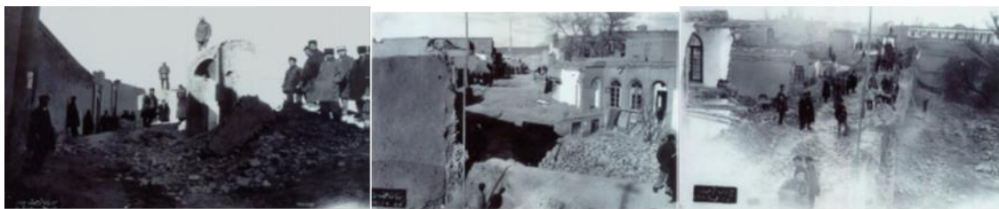
پروژه اجرای خیابان تربیت در زمان ساخت در سال ۱۱۰۳ هجری شمسی
