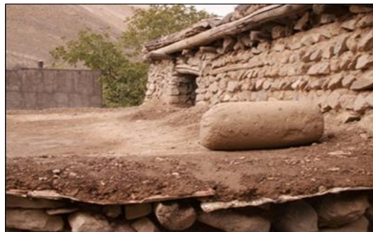
شکل ۱۱. نمونه‌ای از سقف مسکن روستایی
