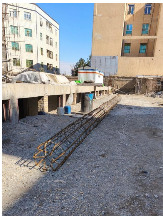
شکل ۷- اجرای لوله‌ها روی قفسه آرماتور
