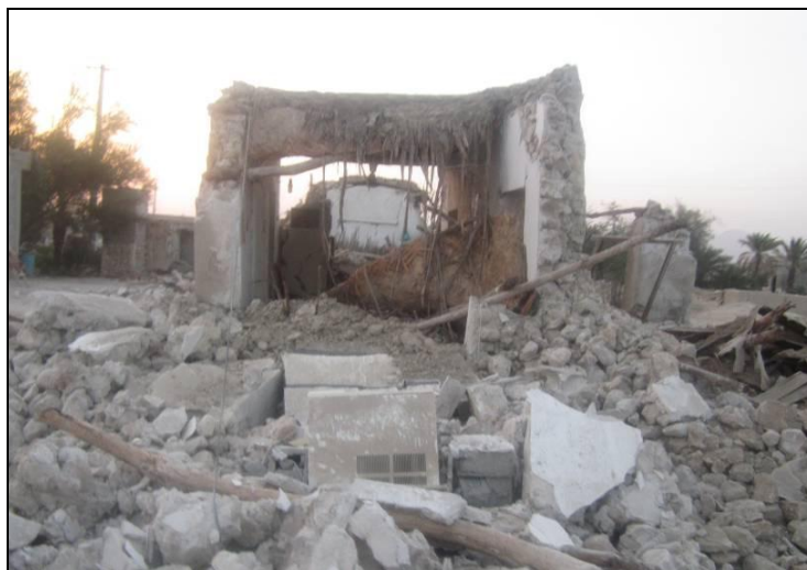
شکل ۱۵- فرو ریختن سقف بر اثر اجرای لایه‌های متعدد کاهگل
