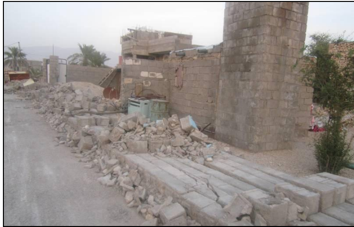
شکل ۱۱- سنگینی دیوارها و ناچیز بودن مقاومت جانبی
