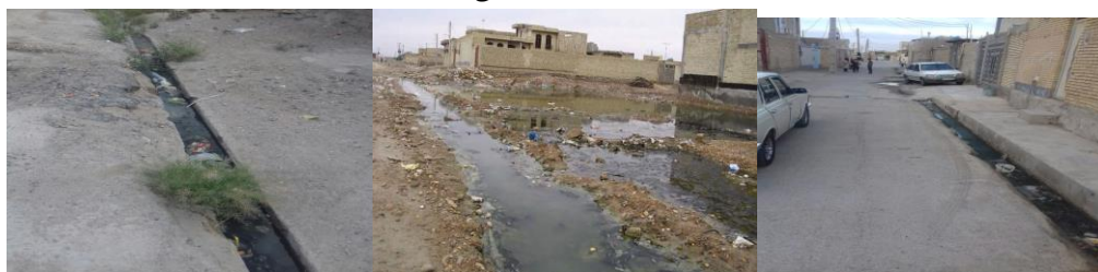
شکل شماره (۴) تصاویر مربوط به مشکل دفع آبهای سطحی در شهر بندر دیلم
