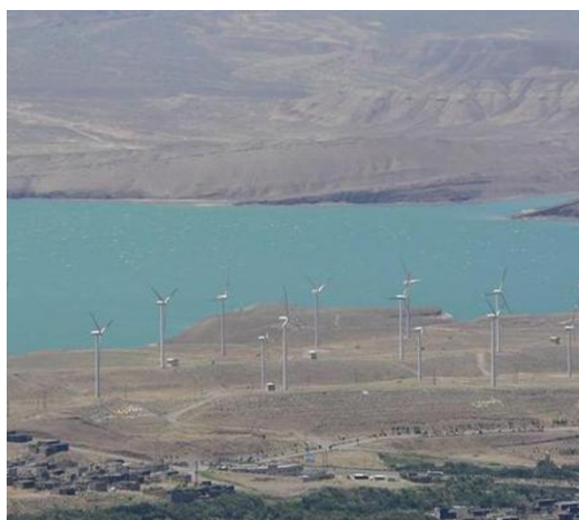
شکل ۶- نمایی دیگر از نیروگاه‌های بادی شهر منجیل
