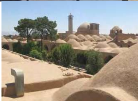
شکل ۸. نمایی از پوشش سقف بناهای بافت سنتی و جدید شهر یزد
